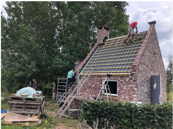
Augustus 2023 Het dak ligt erop
